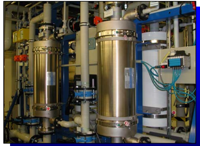
Liqui-Cel 脱气膜组件在IMEC 的使用
