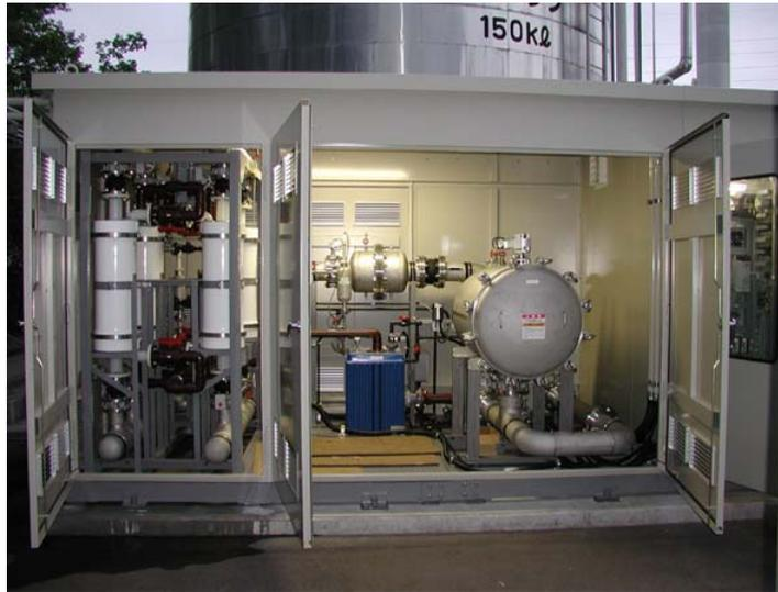
Oxyace® 系统包括：软化器，过滤， pH 控制 (M-碱度控制)，Liqui-Cel® 脱气膜和真空泵。通过系统的自动操作和讯号反馈，用加硫酸将软化水PH值控制在5。每天要加入NaOH以抑制细菌生长。PH值的调节只需要很少的化学品消耗。
