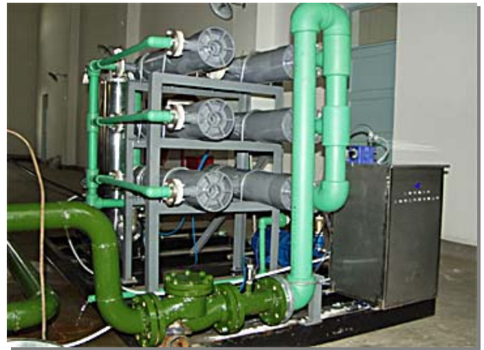
申兰公司用脱气膜制成的锅炉脱氧装置
